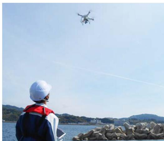
今回の工事は、南建設の創意工夫により、国土交通省が推進する「i-コンストラクション」に沿って試行しました。データ作成は国土交通省が今年3月に発表した「空中写真測量（無人航空機）」を用いた出来形管理要領（土工編）（案）」や国土地理院の「UAVを用いた公共測量マニュアル（案）」に従って実施された。NMBによる海上データとドローンの海上データを統合したことにより、現況地形を連続した面形状として計測でき、数量を3次元的に計算して正確な施工管理が可能になった。今回的方法によつて計測値から算出した捨石の数は約2433立方mとなり、設計数量である
