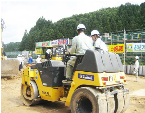
建機の試乗体験も行われた工事現場見学会
