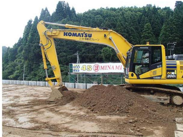
南建設（石川県志賀町）は6月初旬から、世界初のインテリジェントマシンコントロール機能を搭載した「コマツのICT油圧シヨベル「PC200-i」を2台レンタルし、金沢河川国道事務所発注「H27能越道 小泉道路その5工事」（輪島市三井町）の現場で情報化施工を展開している（写真上）。工期は9月末まで。
